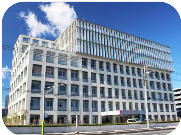
電気設備工事
