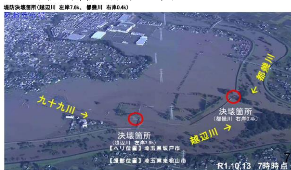
越辺川堤防決壊箇所の洪水直後の状況
