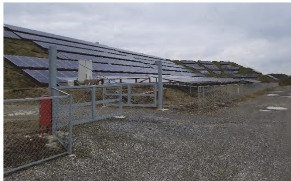
図 2-2-4 境界フェンス
