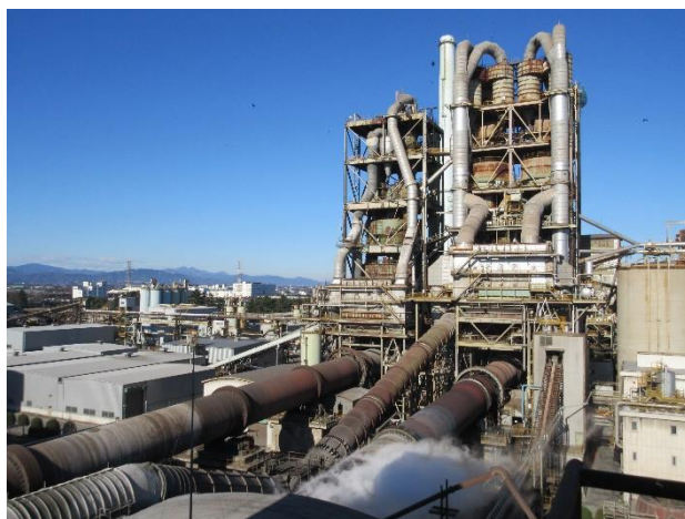
セメント原料化による廃棄物の再資源化を行うセメント工場 (太平洋セメント(株)提供)
