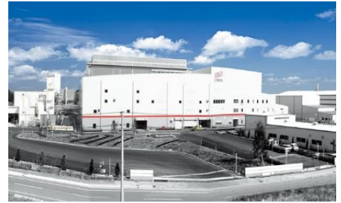
廃棄物発電による熱回収を行う廃棄物処理施設 (オリックス資源循環(株)提供)
