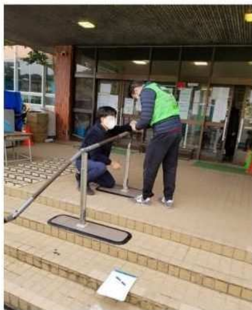
福祉用具業者と一緒に避難所の手すり設置をしている様子
