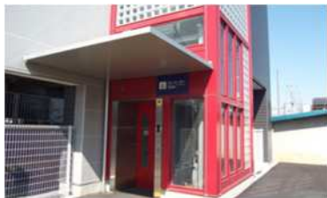
障害者対応型エレベーター
