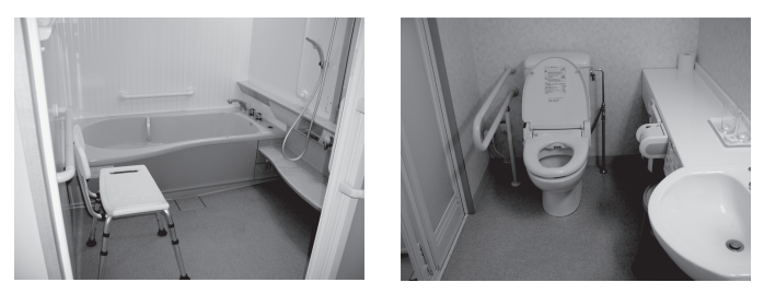
●手すりの設置
