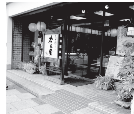
小規模建築物の段差解消
