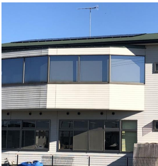
太陽光パネル（補助対象設備）
