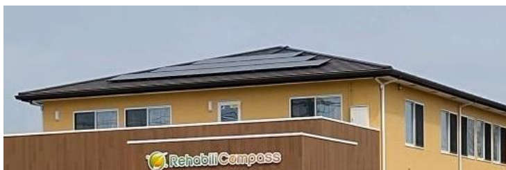
太陽光パネル（補助対象設備）
