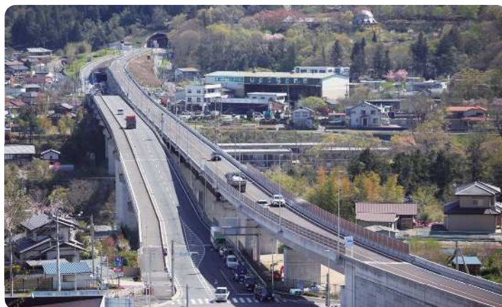
国道 140 号 皆野秩父バイパス
