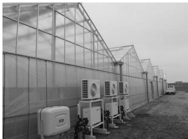
図1 地中熱利用システムの実証試験(イチゴ農園)
