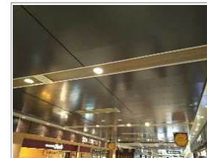
天井板の耐震改修
