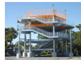
津波避難タワー
