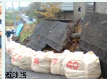
擁壁の防災対策
