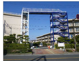
既存施設（市営住宅）へ避難階段設置
