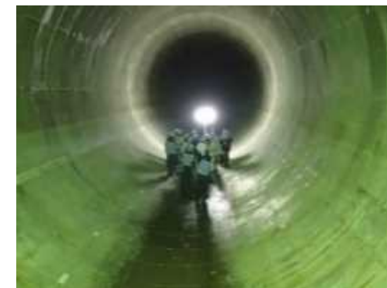
雨水貯留管の整備
