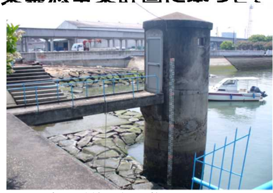
潮位計等の観測施設の設置
