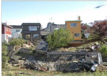
北広島市大曲地区(滑動崩落被害)
