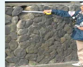
擁壁の危険度調査
