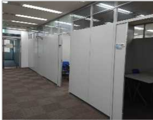
仕切り壁の設置
