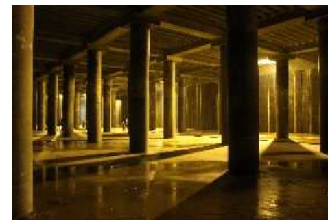
貯留施設の整備
