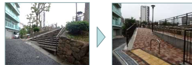
車いす使用者等の移動に配慮し階段をスロープに改修
