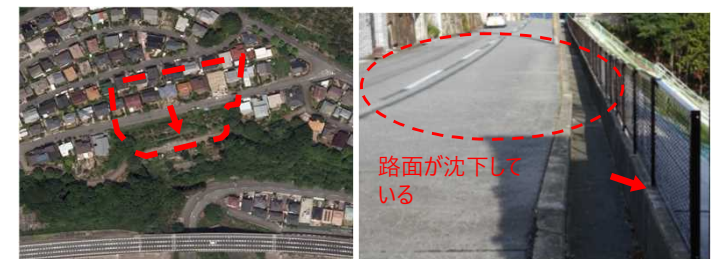
早期に安全性確認が必要と考えられる箇所（イメージ）
