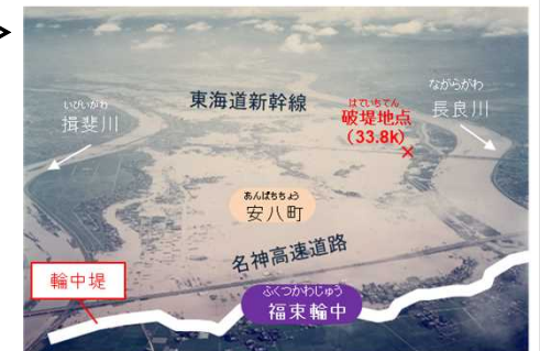
岐阜県輪之内町（福東輪中）
