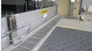
止水板の設置
