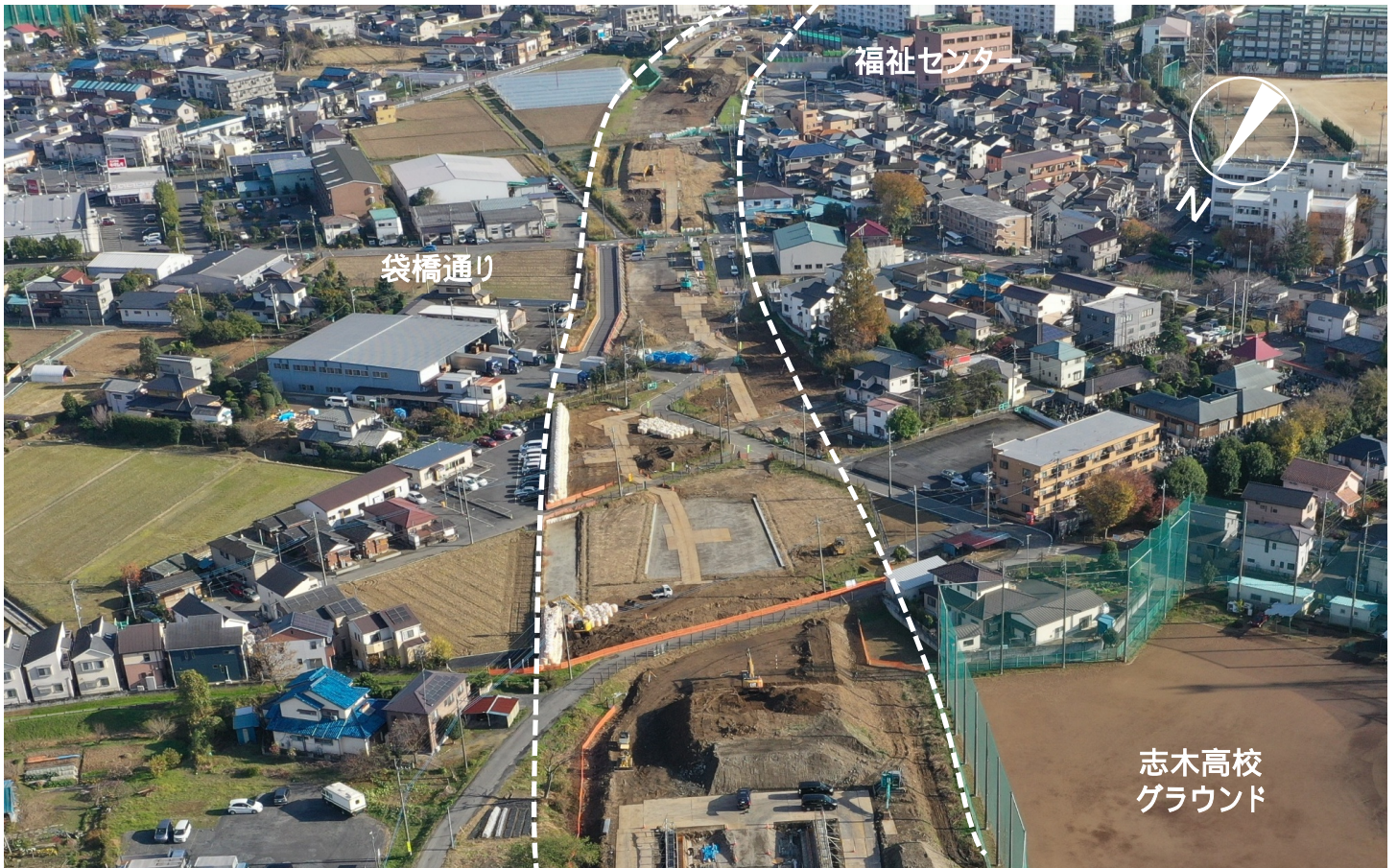
袋橋通り付近（富士見南畑陸橋から和光市方面を望む）
