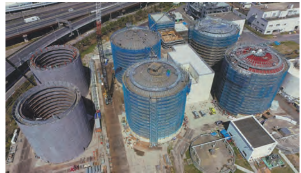
写真1-4 中川水循環センターに建設中の消化槽
