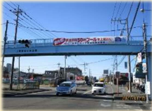
東町歩道橋（水上公園入口）
