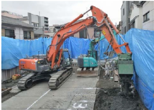
【浅層混合処理工施工イメージ】
