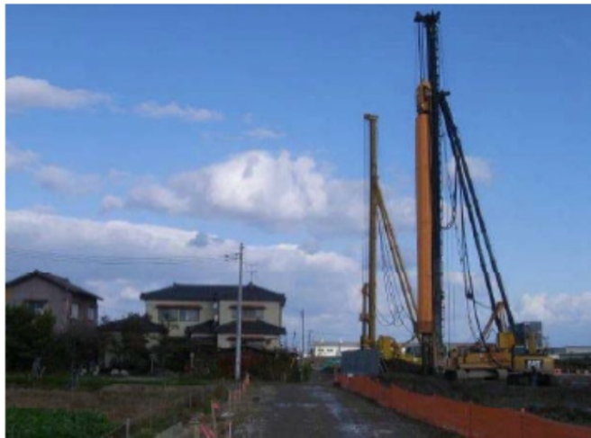
【深層混合処理工施工イメージ】
