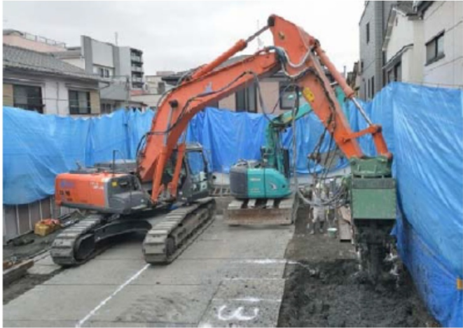
【浅層混合処理工施工イメージ】
