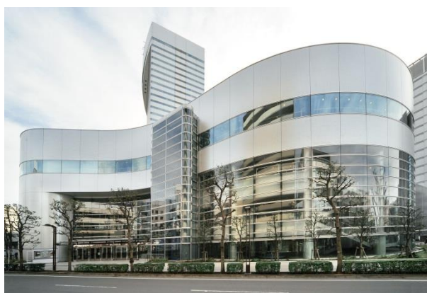
ホール棟外観
