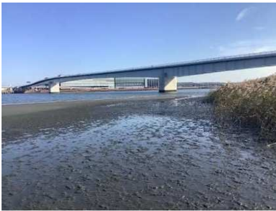
写真 1 完成した多摩川スカイブリッジ
