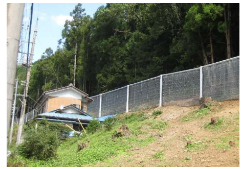
がけ崩れ対策 崩壊土砂防護柵(下モ(ときがわ町))
