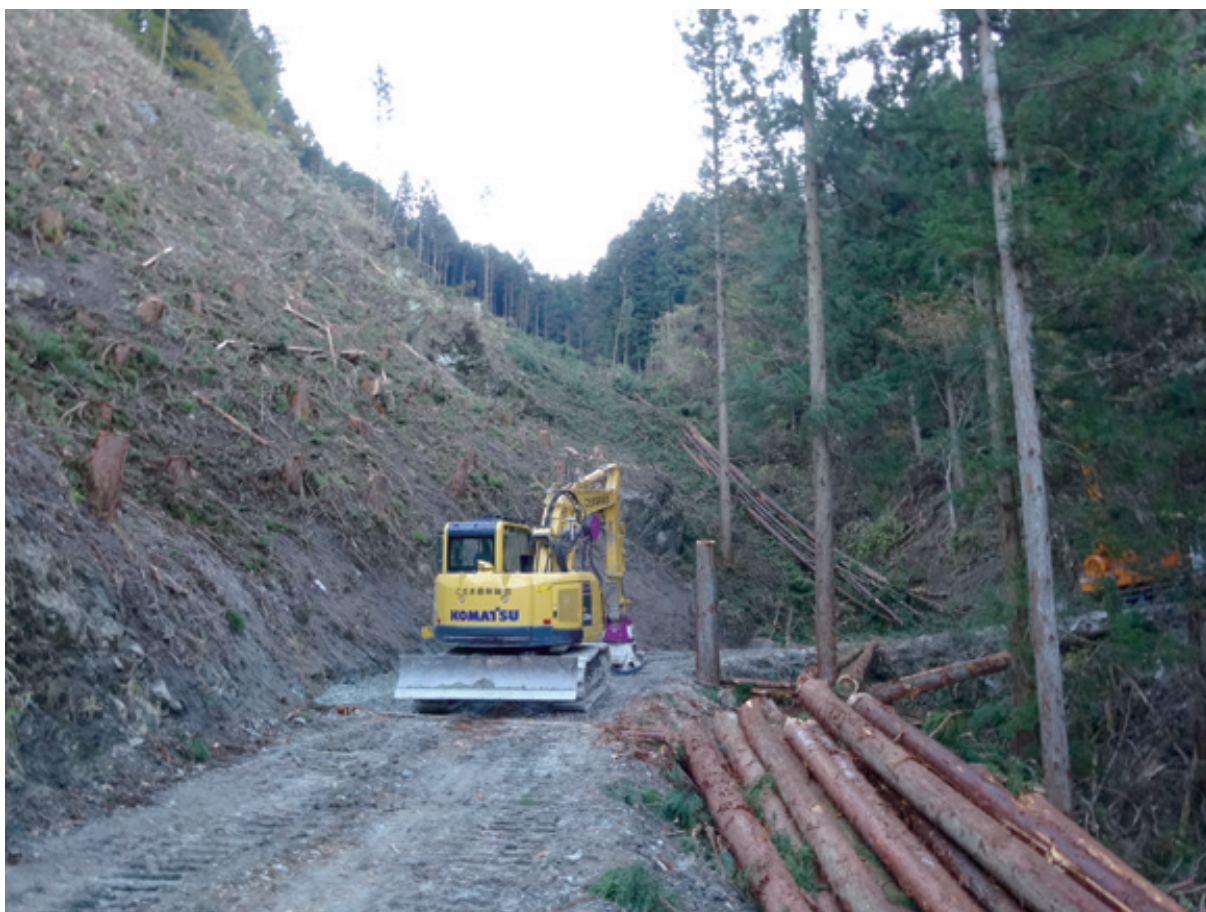
人工林内に作設された作業道
