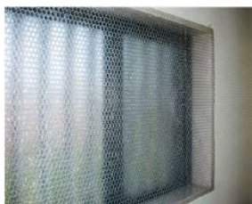
断熱シートの取り付け例
