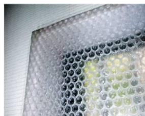
断熱シートの取り付け例
