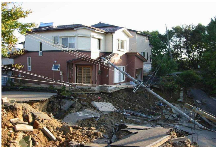
2016 新潟県中越地震の被害
