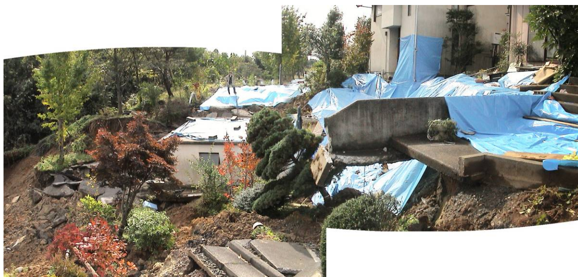
図参 1.1-⑧ 新潟県長岡市高町の盛土造成地の滑動崩落現象その2
