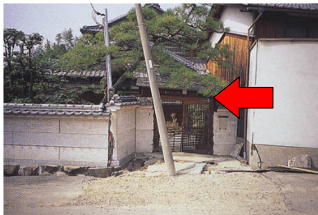
図参1.1-④ 西宮市における盛土造成地の変動に伴う被害（その1）
