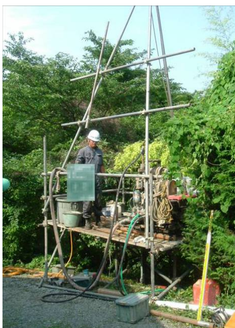
図参6.2-① 調査ボーリング実施風景
