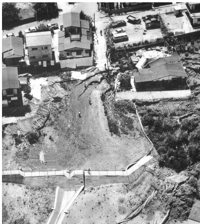
図参 1.1-① 1978年宮城県沖地震による盛土造成地の被害
