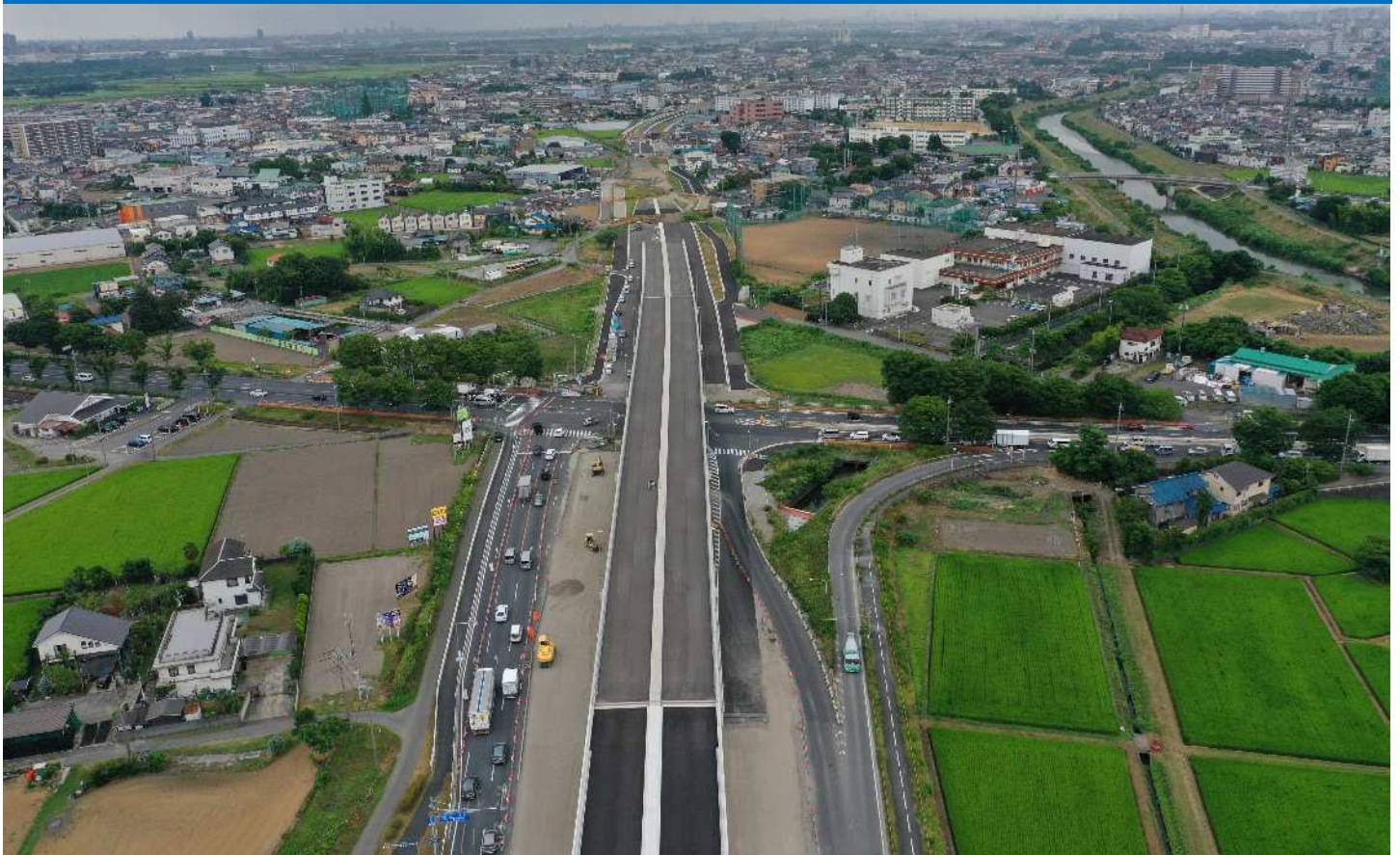
R4.7時点整備状況（国道463号交差点周辺）
