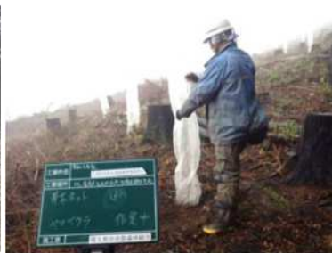
〈獣害防護対策ネット工〉
