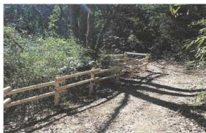
（事業2：木柵の設置状況）
