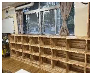
ロッカー取替修繕 （川越第一学童保育室）
