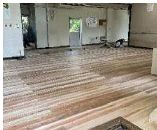
床張替修繕 （名細学童保育室）
