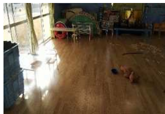
（保育園の床改修）
