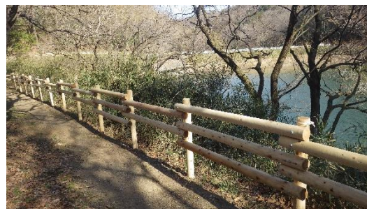
（事業2：木柵の設置状況）
