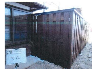
（花久の里外構工事）
