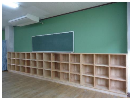
（市学童保育室への木質整備 ロッカー取替修繕（古谷学童保育室））
