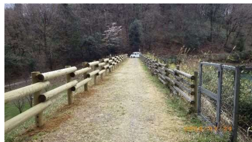
（事業2：木柵の設置状況）
