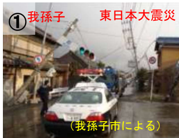
電柱の傾斜・電線の垂れ下り
