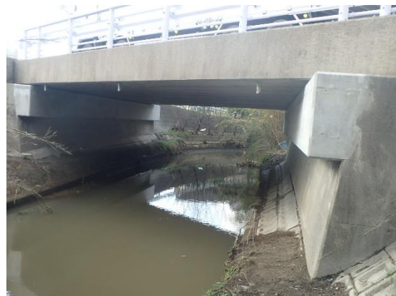
耐震性強化のため橋台を補強（安西橋・春日部市）
