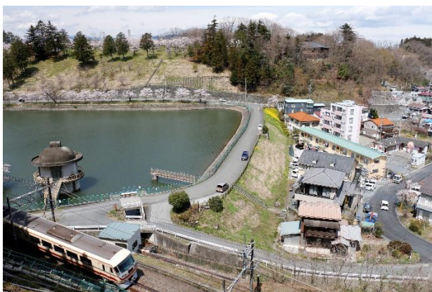
堤体の下流に住宅や道路が近接するため池（姿の池・横瀬町）
