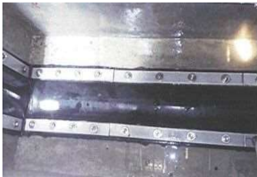
耐震補強工事事例【目地部】
