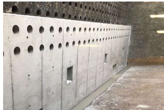
耐震補強工事事例【壁面部】
