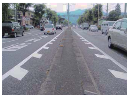
コンクリートで被覆
