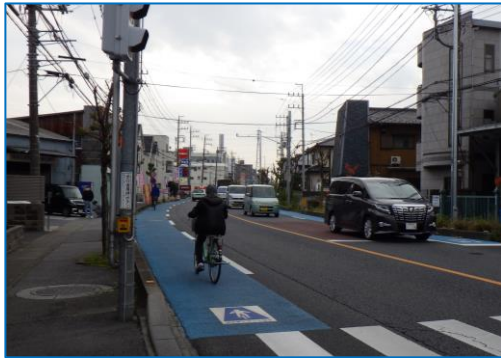
交通規制により指定された、自転車が専用で通行する車両通行帯。 自転車と自動車を視覚的に分離
