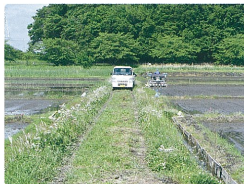
▲【整備前】狭い農道、水が流れにくい土水路
