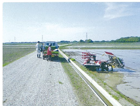
▲【整備後】広い農道、水が流れやすい護岸水路
