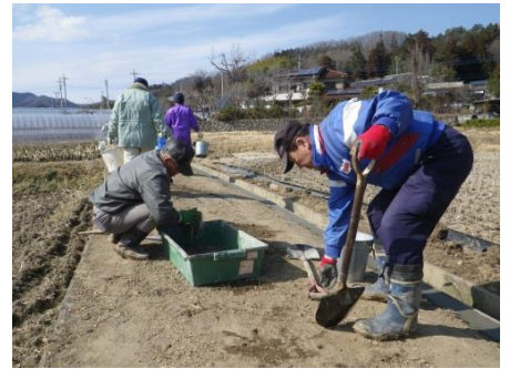
③水路補修
