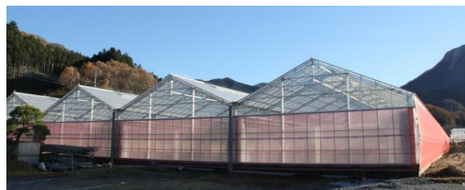
事業により再建された大型いちごハウス
