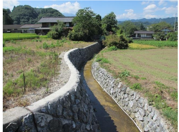
補助事業により整備された排水路
