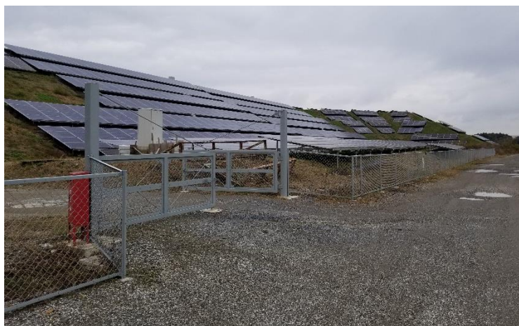
図2.6-11 境界フェンス
