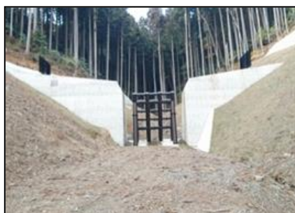
砂防堰堤工／慈光寺川
