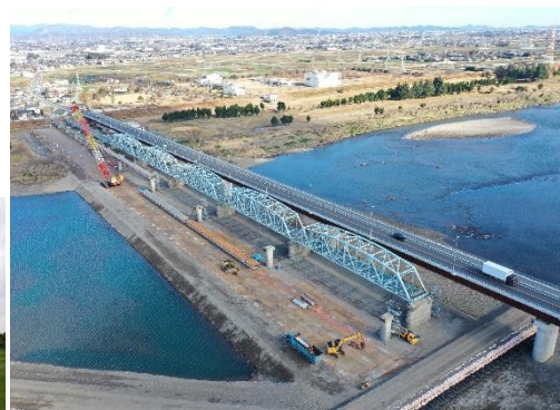
橋りょう架換え工事 伊勢崎深谷線(上武大橋)
