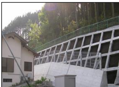
急傾斜地崩壊対策工／細入地区
