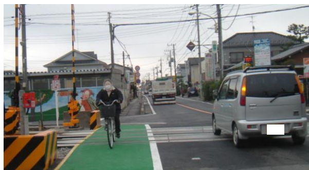
踏切拡幅例（春日部松伏線）
