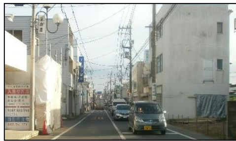
整備実施箇所（東武動物公園停車場線）
