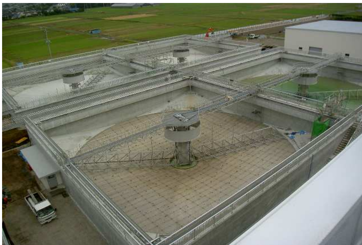
図 2-5 汚泥濃縮槽(南西側より撮影)
