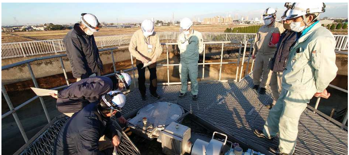
図 2-33 揺寄機の運転・劣化状況の確認
