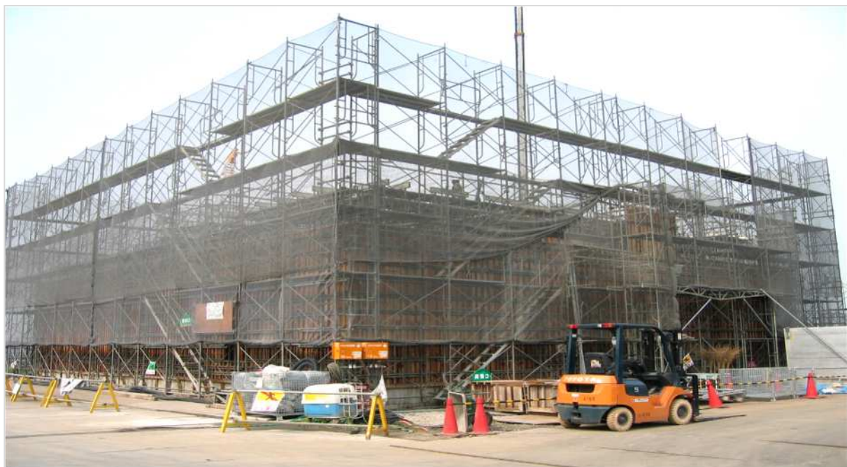
図 2-4 発電棟(南西側より撮影)
