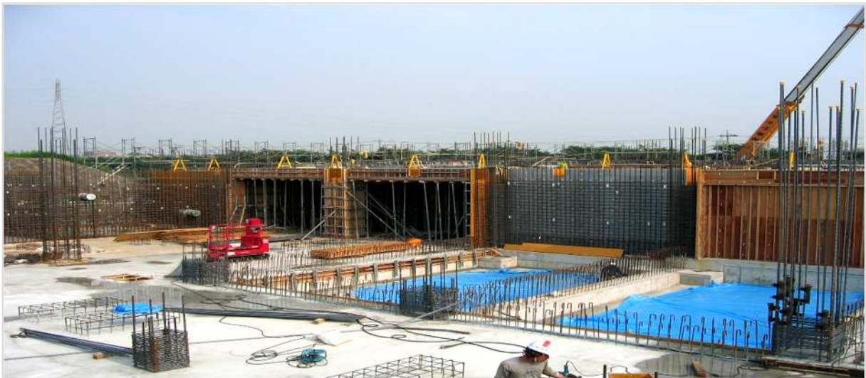
図2-2 脱水棟(北側より撮影)
