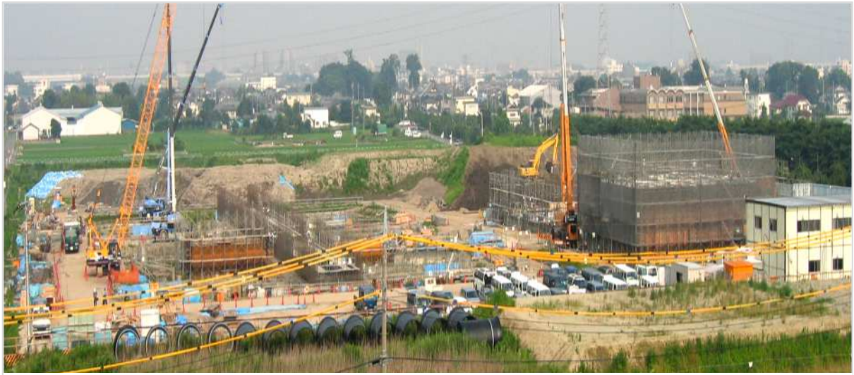
図 2-1 建設状況全景(西側より撮影)
