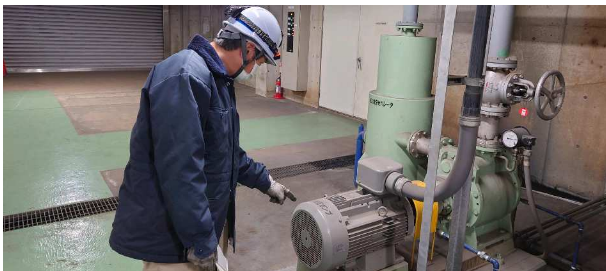
図 2-35 ポンプの運転・劣化状況の確認
