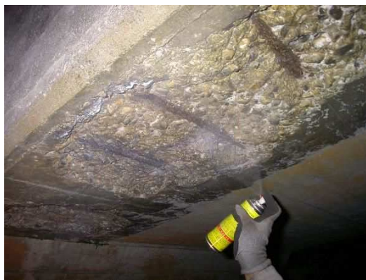
《新技術のワンプッシュスプレー施工》
