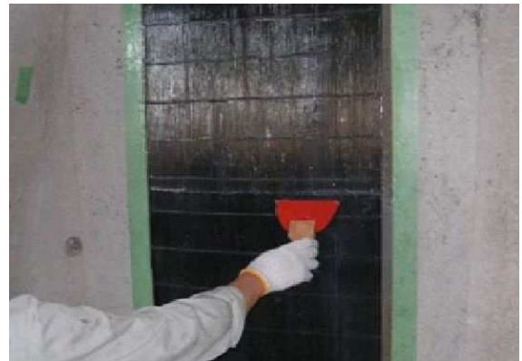
《ストランドシート貼付工》
