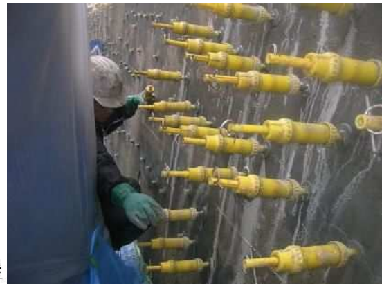
《リハビリシリンダー工法 施工状況》
