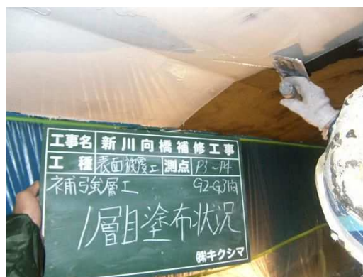
《補強層(ウレアウレタン樹脂)施工写真》
