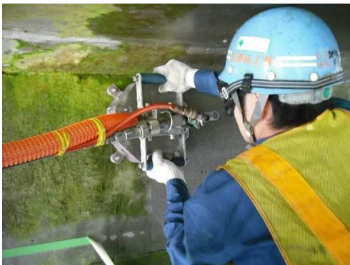
《施工写真(横向き施工)》
