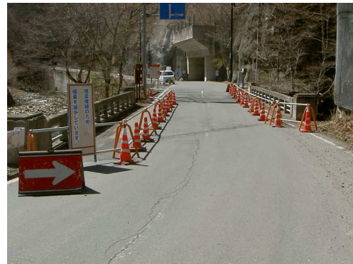
写真 4.8.32 路肩規制状況 (2)
