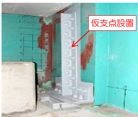
写真 4.8.24 仮支点補剛材施工状況
