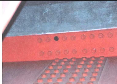
《添接部のボルト脱落状況》 8
