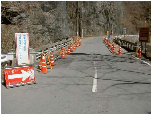
写真 4.8.31 路肩規制状況 (1)
