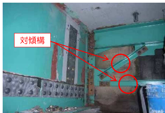
写真 4.8.25 改修終了状況
