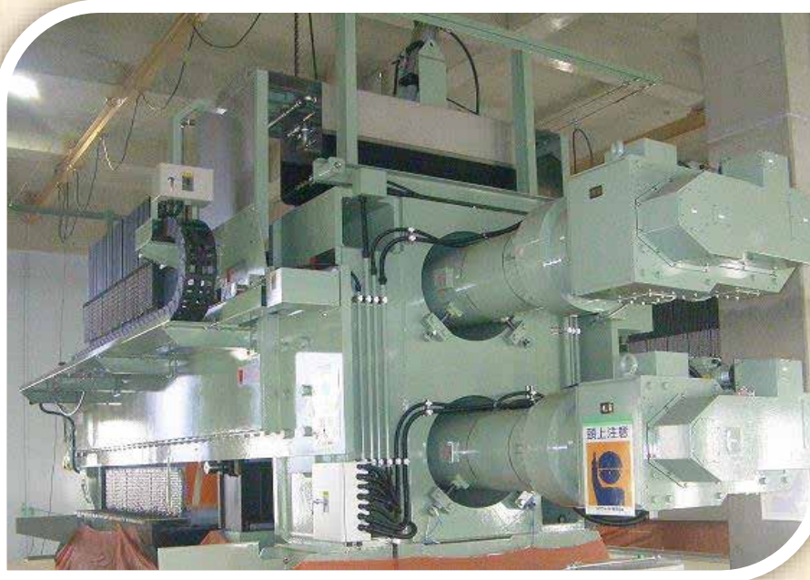
柿木浄水場 排水処理設備 脱水機(草加市)
