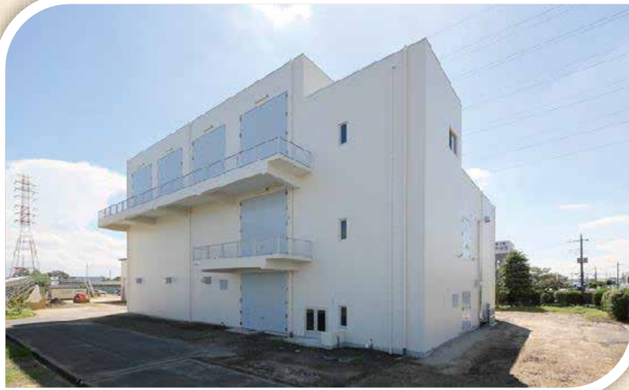
柿木浄水場 排水処理棟(草加市)
