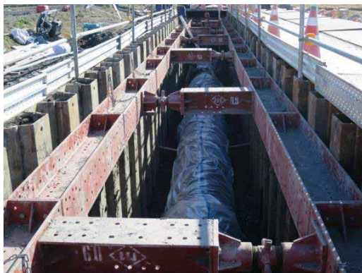
東松山第二幹線送水管(φ1,100)布設状況 (川島町)
