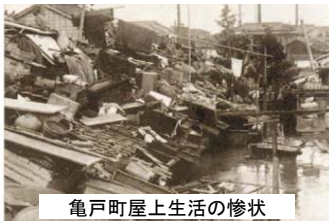
亀戸町屋上生活の惨状
