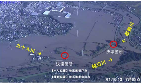
入間川流域における浸水被害状況
