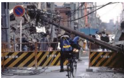
阪神淡路大震災における電柱倒壊 (国土交通省HPより)
