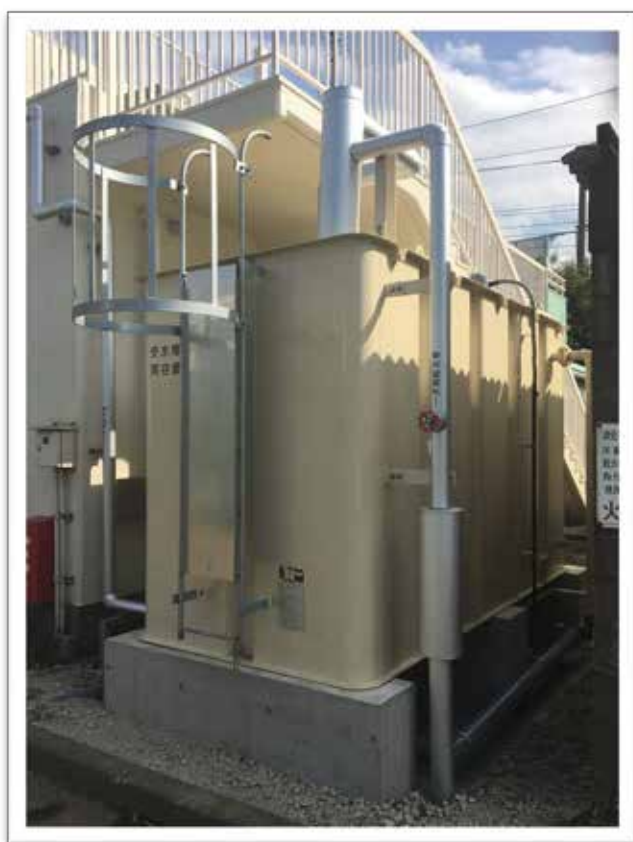
20 t ラフターを使用し荷取り後 横引き搬入・据付いたしました
