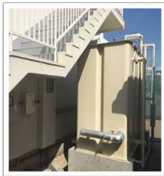
20 t ラフターを使用し荷取り後 横引き搬入・据付いたしました
