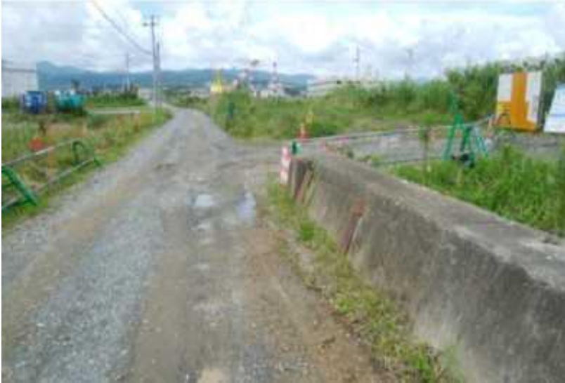
気仙沼市波路上漁港付近(沿岸の市道港岩井崎線)
