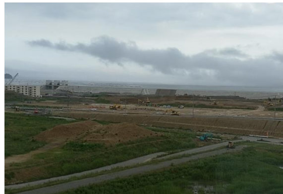
陸前高田市嵩上げ工事の様子
