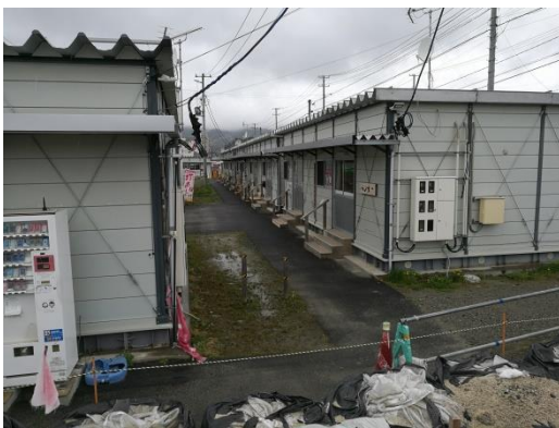
山田町の仮設店舗
