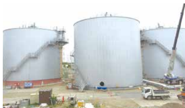
写真1-2 元荒川水循環センターに建設中の消化槽
